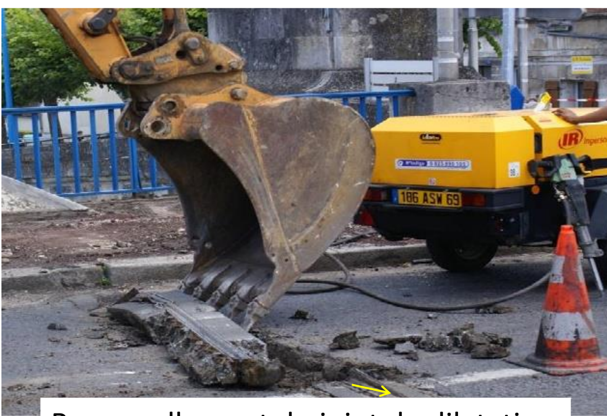
Renouvellement du joint de dilatation
