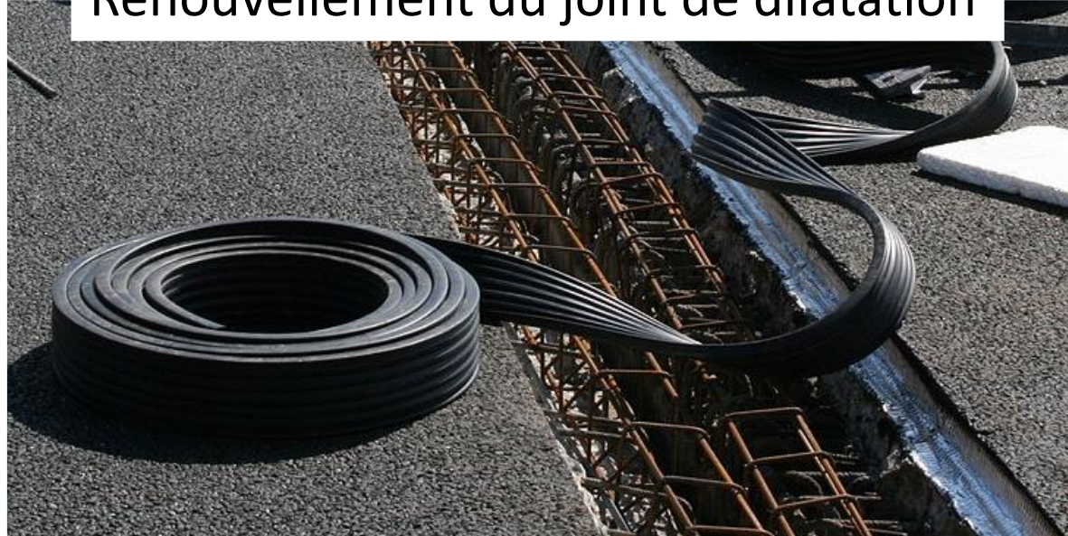
Renouvellement du joint de dilatation
